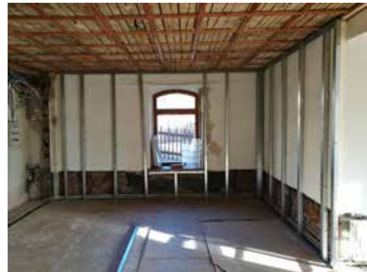
im Februar 2019 steht das Ständerwerk für die Wandverkleidung
