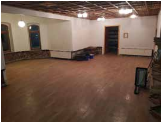
die alte Decke ist raus und die Holzverkleidung entfernt
