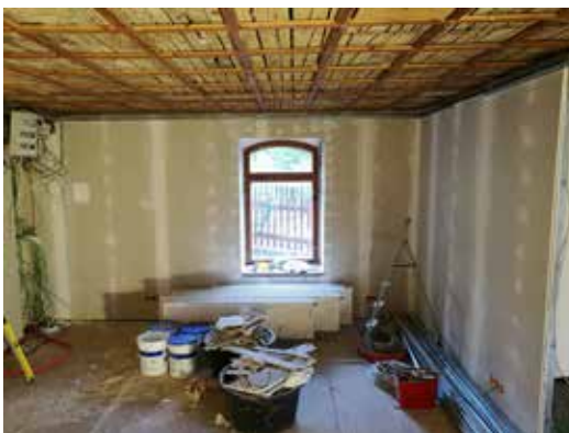
Platten sind dran und verspachtel
